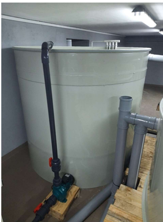
Рис. 1. Біофільтр для рухомого та нерухомого біозавантаження
